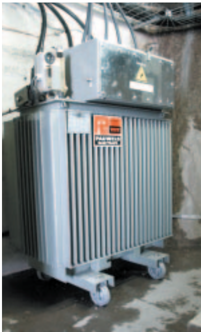
250 kVA SLIM® de Pauwels avec technologie d'isolation thermique DuPont™ NOMEX®
