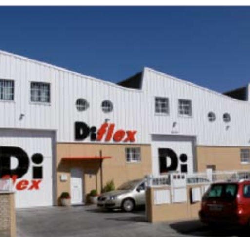
Las instalaciones de Diflex en Madrid
